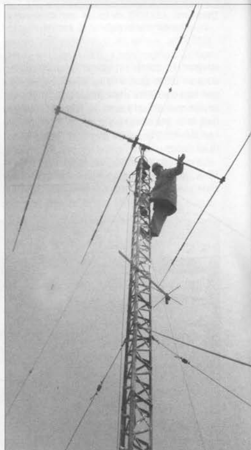
Carlos, XE1GC, completamente equipado y en lo alto de su torre.
