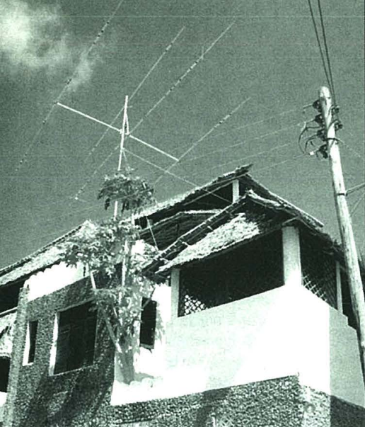
Las antenas y las líneas eléctricas.
