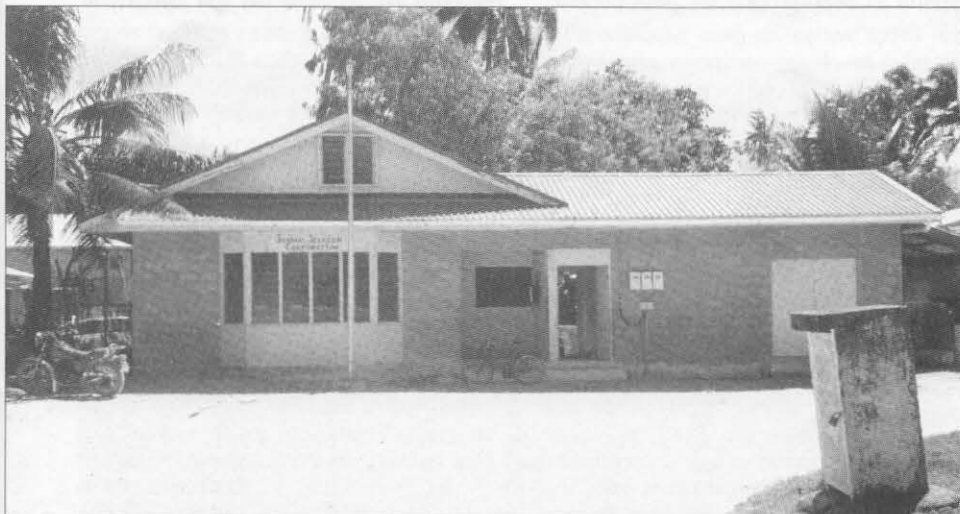
En el pequeño edificio de «Tuvalu Telecom Corporation» le fue concedida la licencia de T24DX.
