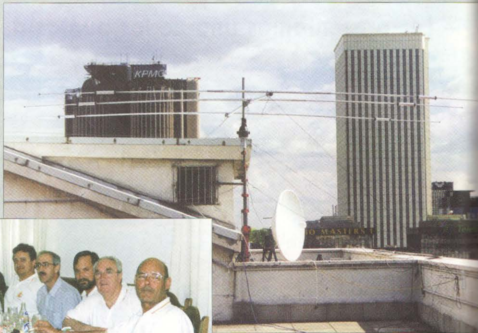
Vista de la antena, montada sobre un mástil telescópico de la II Guerra Mundial, cedido por el Parque Central de Transmisiones del Ejército de Tierra.
