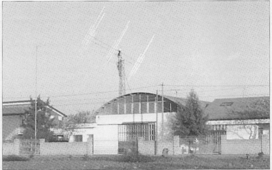
Vista panorámica de la antena de RL de I3DLI.
