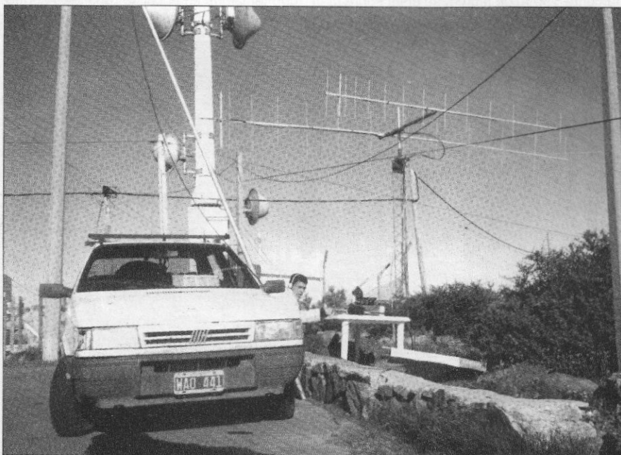
Antenas Yagi utilizadas.
