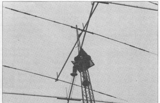
Roberto, EA1BVP, montando la antena tribanda y la directiva de dos elementos para 40 metros.
