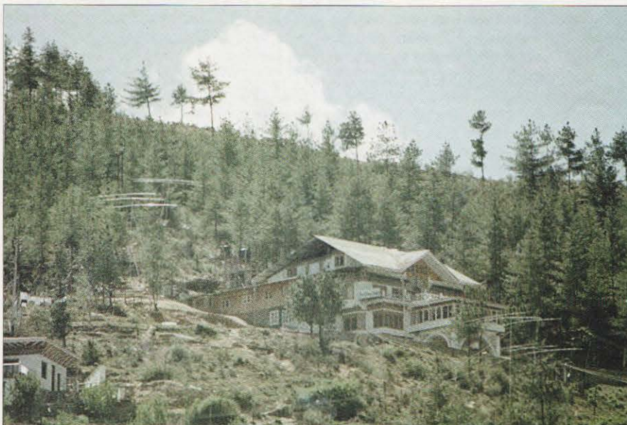
El campo de antenas. En la montañoso Bután es virtualmente imposible lograr una situación perfecta sin obstáculos para todas las áreas.
