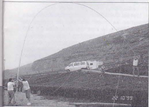
Levantando la vertical Titanex para 160 metros.
