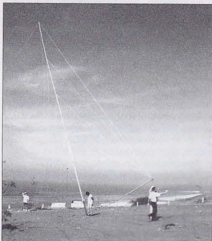
Levantando una de las verticales para 80 metros.
