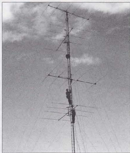
Mástil de 24 m de alto con la antena de 4 x 4 elementos para 10 metros.
