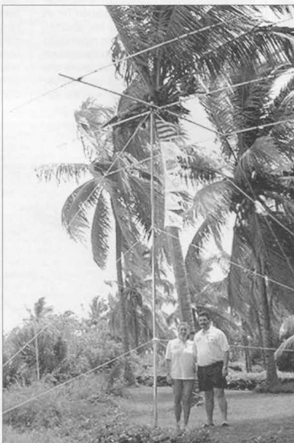
A pesar de la relativamente escasa altura del mástil, el régimen de brisas marinas de la región aconseja un arriostado elaborado.
