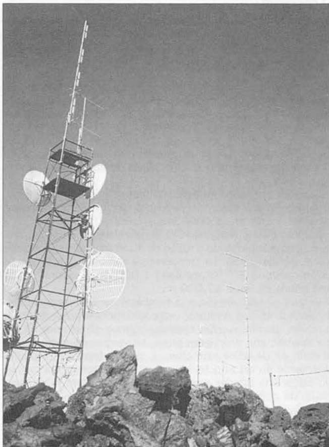
Estas torretas, en la falda del volcán Mauna Loa, soportan las antenas de las balizas de KH6HME. Cuando la banda se abre hacia la costa Oeste, Paul desconecta las balizas y empieza a hacer contactos. La colineal de 8 secciones en lo alto se usa para contactos en 2 metros FM durante el verano.
