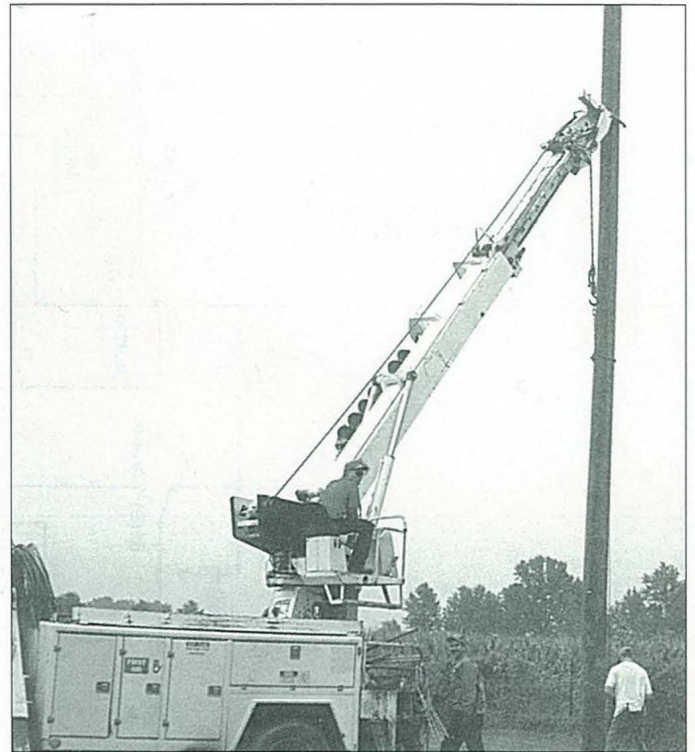
¿Cómo se erigen postes como estos? ¡Por supuesto uno no debe hacerlo solo! Requerir alguna ayuda mecánica es una buena idea. Para facilitar las fases posteriores de montaje, las poleas se sujetaron a los cáncamos antes de que los postes fuesen instalados.
