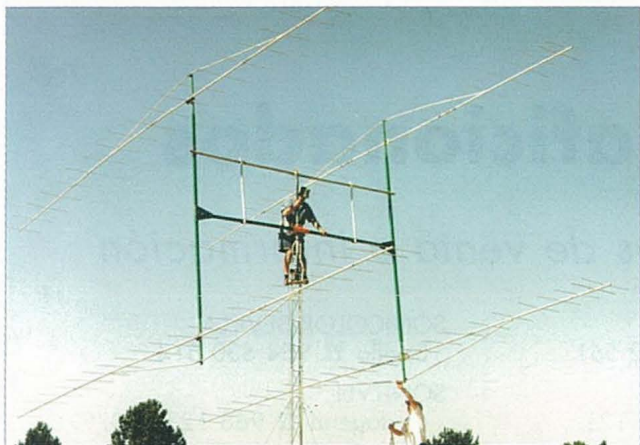
Francesc, EA3AYX, encaramado en lo alto de la torreta, instalando el enfasador y el control de elevación.
