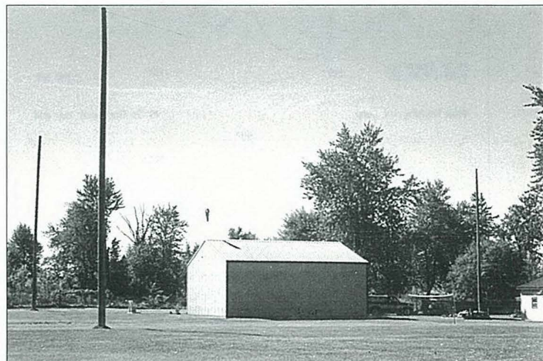
Tres de los cuatro postes formando las esquinas de la antena de bucle. La colocación de los cuatro postes requirió algún recorte de los árboles. (Fotos realizadas por el autor).
