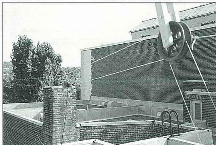
El sistema completo. Véase que los cables se mantienen perfectamente paralelos. Esto se logra repartiendo el peso de la línea entre los hilos superior e inferior, así como por la tensión variable en cada extremo.
