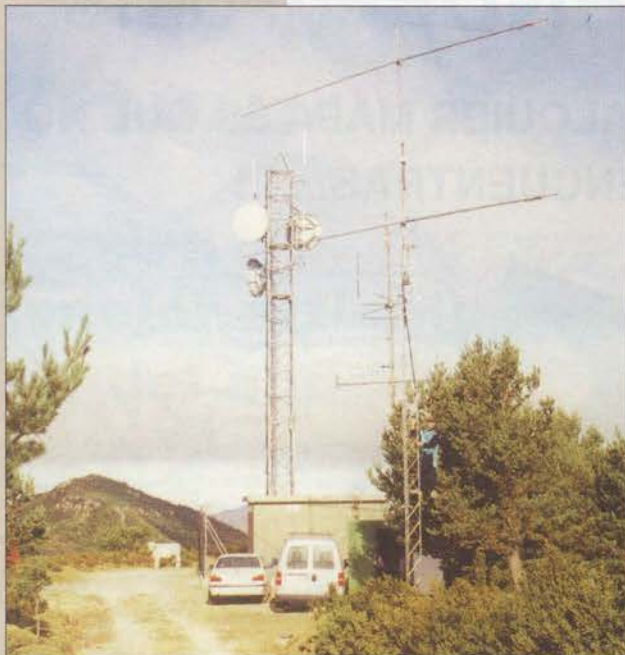
EA2URE desde IN92ri. EA2KU en la torreta con 2 x 17 elementos Yagi apilamiento vertical.
