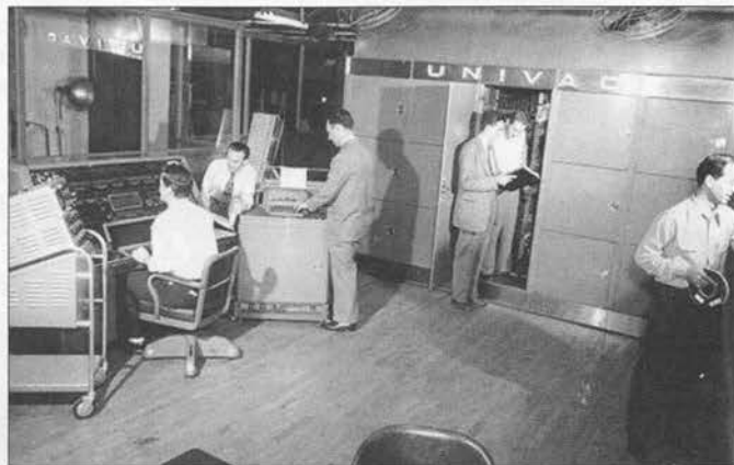
Foto A. El UNIVAC. La consola central aparece a la izquierda, y una pequeña parte del panel principal aparece a la derecha. Nótese el osciloscopio al fondo a la izquierda, utilizado para diagnóstico y comprobación. (Foto cortesía de John W. Mauchly Papers, Rare Book & Manuscript Library, Universidad de Pennsylvania).
