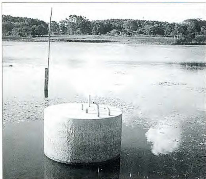
Base de hormigón antes de instalar la torre. Un tubo cerrado de PVC contiene el hilo imagen de 0,25 \lambda .
