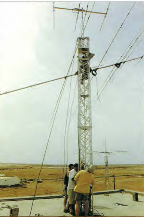
En lo alto de la torre núm. 2, Alberto, IV3TAN, trata de poner en posición la antena C4XL.
