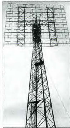
Antena de 64 dipolos para 111,4 MHz del Proyecto Diana. Permitía escuchar ecos lunares 20 dB sobre el ruido de fondo utilizando un transmisor de 3 kW.
