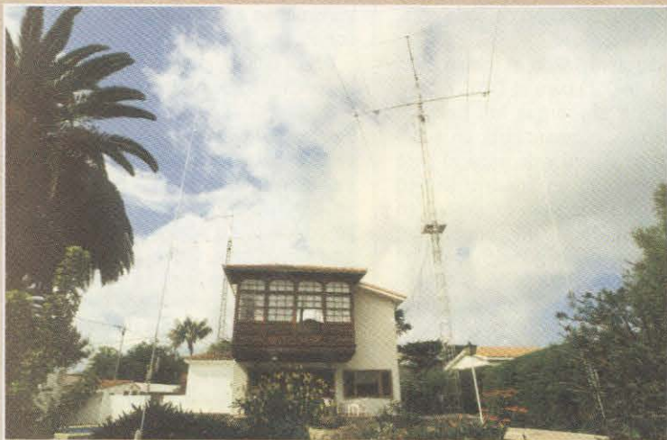
Desde esta espléndida instalación en su segunda residencia de Tenerife se hace oír en el aire nuestro amigo Fernando, EA8AK.
