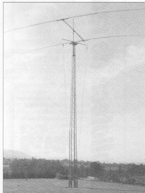
La torre principal en la que se encuentra «La gaviota», la Yagi monobanda de 2 elementos para 40 metros de Cab Radar. Y los dipolos de onda completa en V invertida para 80 y 160 metros.
