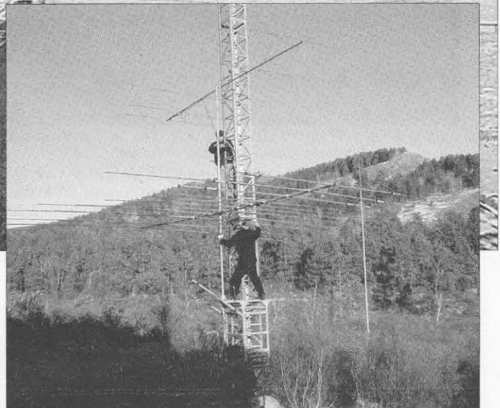
*JT1BG (arriba) trabaja en la nueva antena direccional para 6 metros de JT1CO, mientras JT1KAF (debajo de la TH-11) sujeta firmemente el mástil. (Fotos del autor).*
