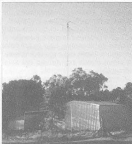
El dipolo en V invertida para 1,8 MHz de VK6VZ, a 27 m de altura, está sostenido por un mástil de extensión en aluminio y fibra de vidrio y montado sobre una Yagi tribanda reconstruida, de Wilson System.
