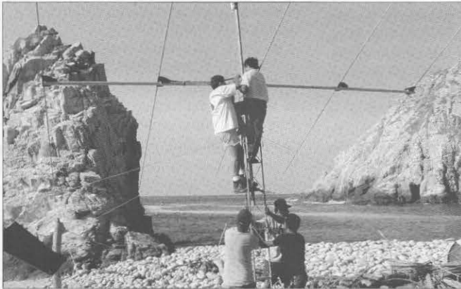
Instalación de la antena tribanda.
