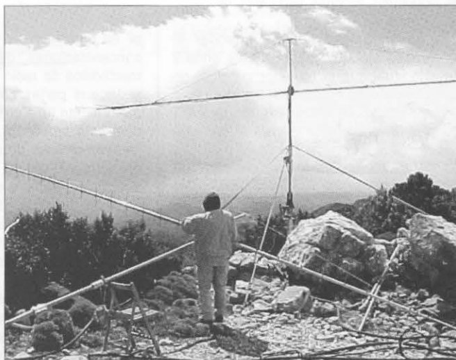
EA2TJ en plena faena intentando meter en el mástil la Yagi de 38 elementos para 432 MHz.
