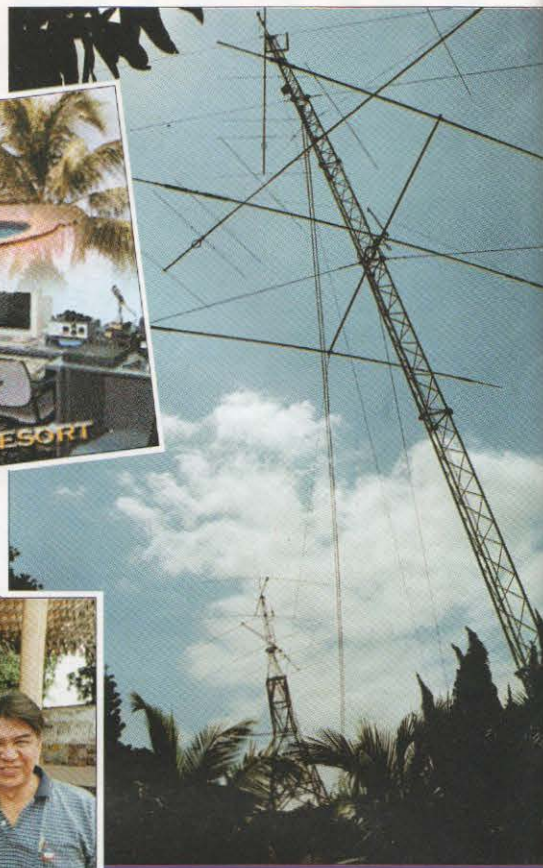
En primer término, una torre con dos Yagi para 50 MHz y una de tres elementos para las bandas WARC. Al fondo, la torre principal con las Yagi para 20 y 40 metros.
