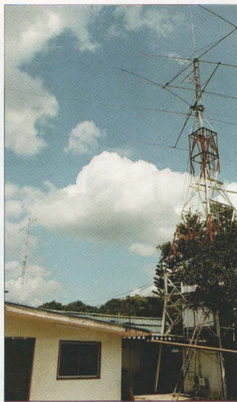
La torre principal, con las antenas para 40 y 20 metros, así como algunas para VHF.
