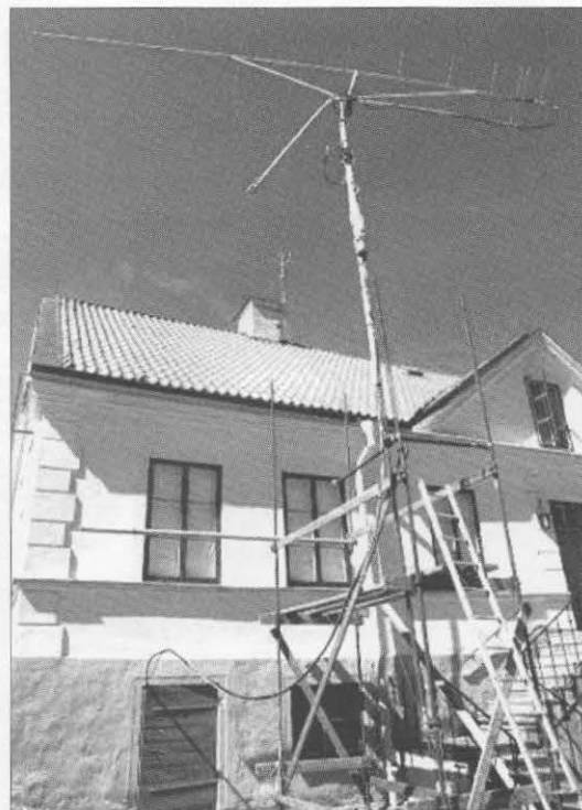
Antena provisional de 13 elementos de Leif, SM5BSZ, para RL con la que ha logrado espectaculares resultados.
