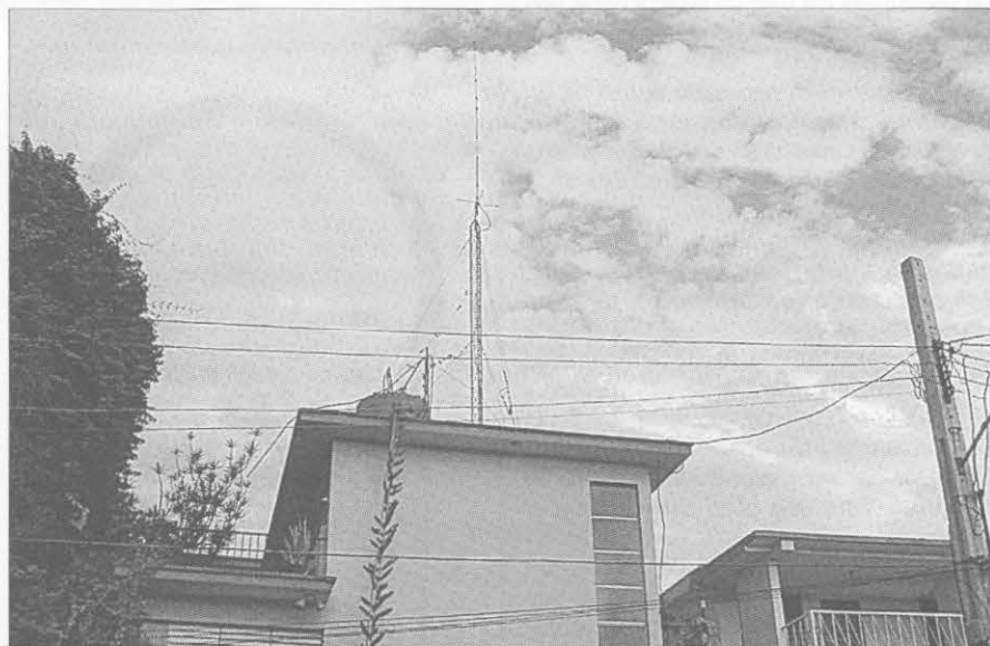
Foto A. Antena omnidireccional de tamaño natural para la banda de 2 metros polarizada verticalmente, en el QTH de CO2KK, que utiliza tres elementos de 5/8 de onda. Con una ganancia estimada de 6 dB sobre un dipolo, es mi estándar de comparación para el trabajo en FM en 2 metros.
