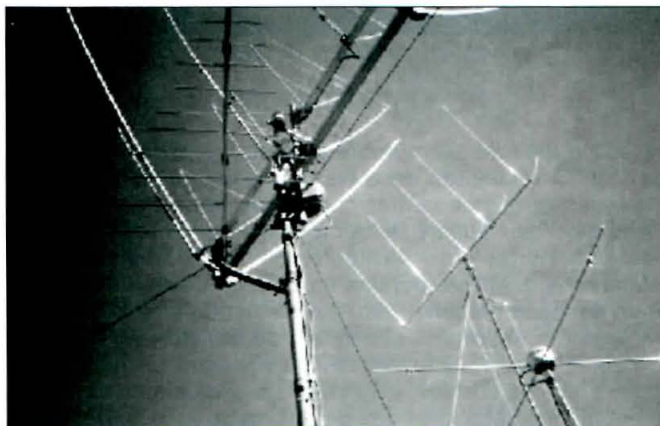
Vista de varias antenas «delta loop» para las bandas de 6, 10 y 2 metros.
