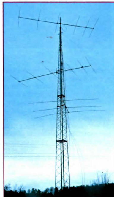
Las antenas y los cables oscilan violentamente bajo la tormenta.
