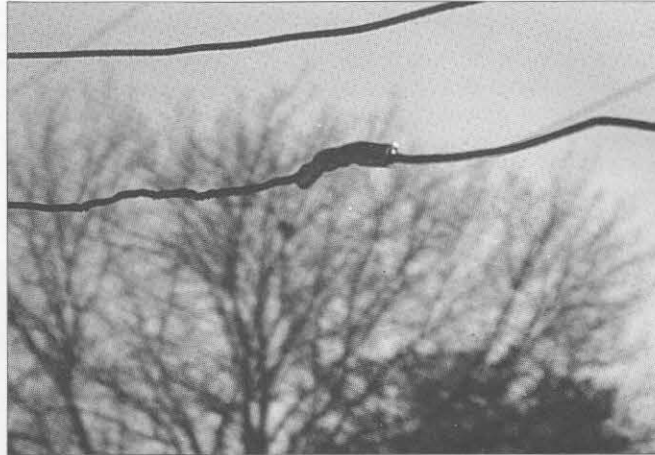
Foto E. Conexión a presión (no soldada) que se usó para extender la longitud de la antena de 10 metros, cuyo hilo original era demasiado corto. A los «puristas» de las antenas quizá no les agrade, pero el sistema cumple las especificaciones marinas.
