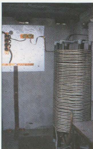
La bobina de carga de la antena de onda media, de dimensiones considerables, está encerrada en un recinto independiente.
