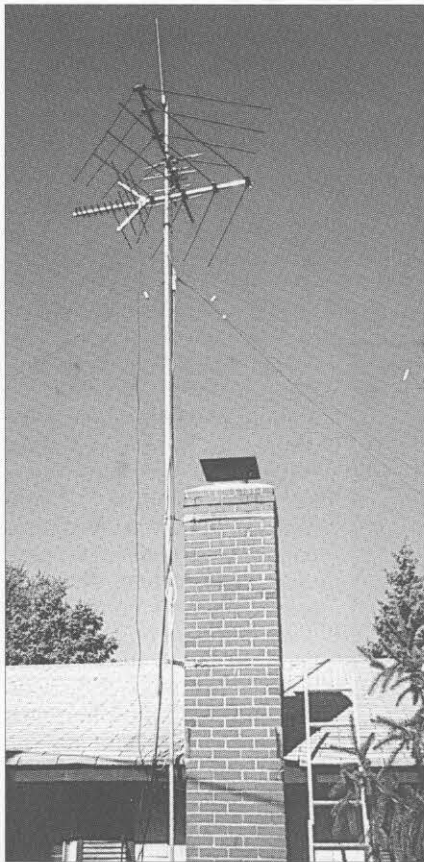
Foto B. Al compartir el espacio con un mástil metálico fijado a una chimenea, es esencial el utilizar línea coaxial en lugar de línea de escalerilla, que la haría más tolerante con las desadaptaciones. Sin embargo, la línea de escalerilla podría verse afectada por el mástil metálico, haciendo que éste radiase.
