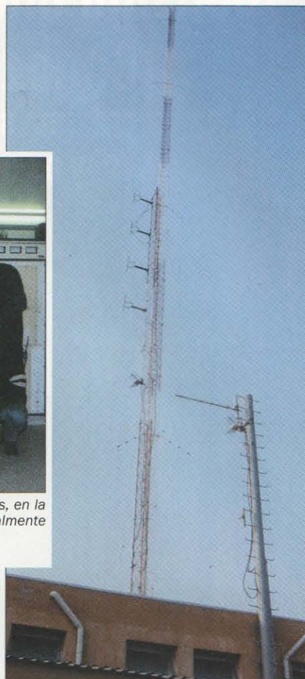
Una alta torre sirve como radiante de la señal de AM en 783 kHz, mientras otra, próxima, aloja el grupo de cuatro antenas para el transmisor de FM en 102,0 MHz.
