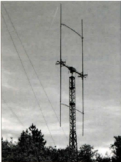
Impresionante vista de la nueva torre de EA2LU y de la estructura en «H» que soportará las 8 antenas (dos conjuntos de 4 en vertical).
