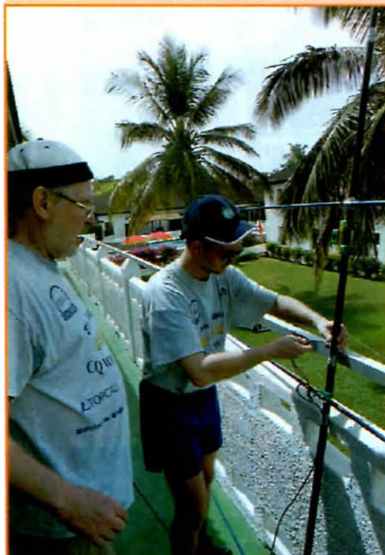
OH3BHL (izquierda) y OH9MDV, montando la antena Yagi para 50 MHz
