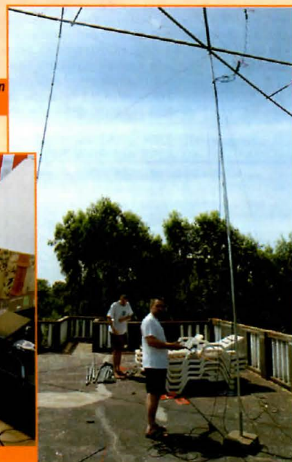
Trabajando en el montaje de las antenas de la estación núm.2; verticales y triángulos de hilo.
