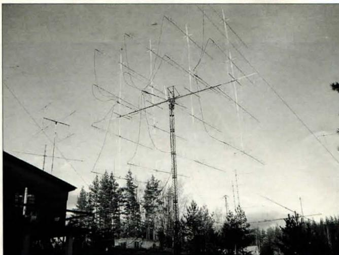
La impresionante nueva antena de RU1AA para RL en 144 MHz (16 x 14 el. con doble polaridad)
