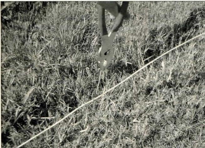
Foto C. El gancho se clava en el suelo para fijar el radial.
