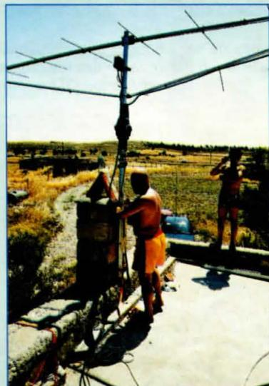
Andrea, HB9DUR, alista la larga antena Yagi que se usó en 2 metros para los contactos en MS. Puede apreciarse el perfil de la isla, bastante plana y muy soleada, aunque fértil.
