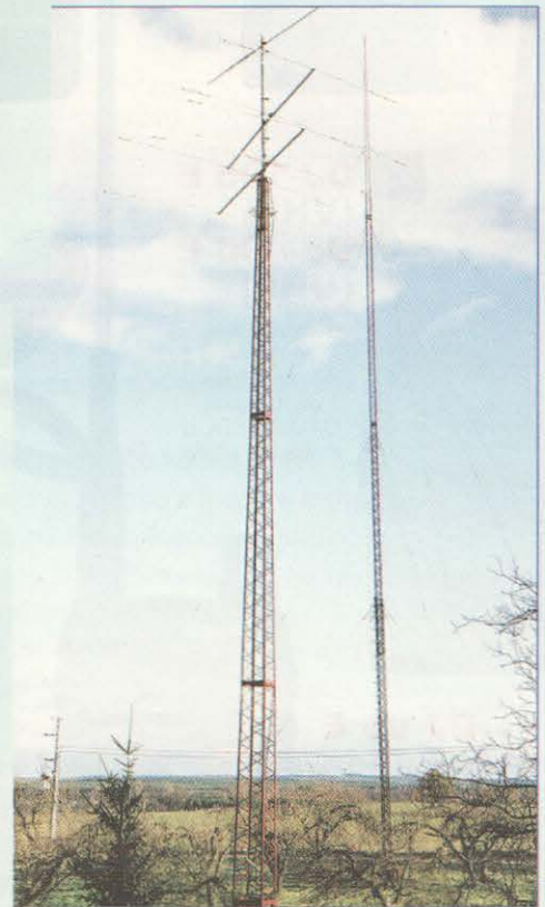
En primer plano, las antenas Yagi para las bandas WARC y detrás, la antena vertical para bandas bajas de SP2FAX.
