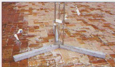
Soporte en forma de Y que sostiene la torreta, sujeta simplemente con tres fijaciones. La Y no va fijada con nada en el suelo.
