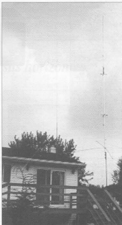
Foto E. Las antenas verticales multibanda de nuevo diseño, tal como la Gap Titan son fáciles de instalar por uno mismo, funcionan realmente bien y muestran una apariencia limpia y amistosa con los vecinos. Haciendo uso de una base abatible, pueden incluso ser bajadas y escondidas cuando sea necesario.
