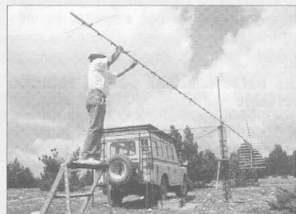
El montaje una antena de grandes dimensiones tiene su complejidad.
