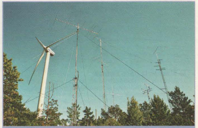
El campo de antenas de OH0JHP, en el locator KP00ab, que comparten con un aerogenerador.
