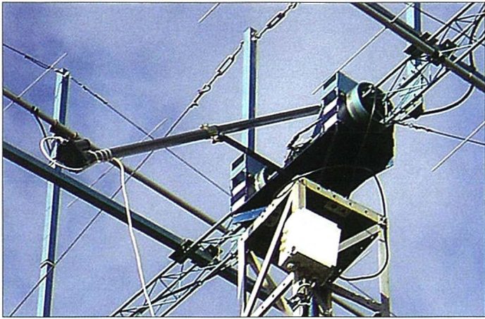
Foto 2. Soporte central del sistema, mostrando el mecanismo de elevación.
