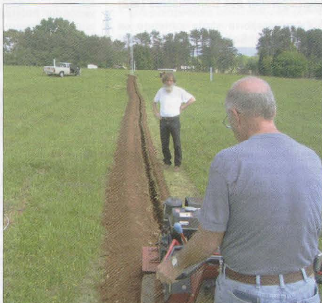
Lynn, W4NL, de Maryville, TN, que opera en QRP y por ello necesita aprovechar hasta el último vatio, decidió recientemente reemplazar algunos coaxiales de su estación. Adquirió un centenar de metros de coaxial sólido de 1 5/8" y alquiló una máquina para efectuar una zanja de un par de decímetros entre su casa y la torre. En la foto, Donn, W4TO, está llevando la máquina mientras Lynn controla el trazado.
