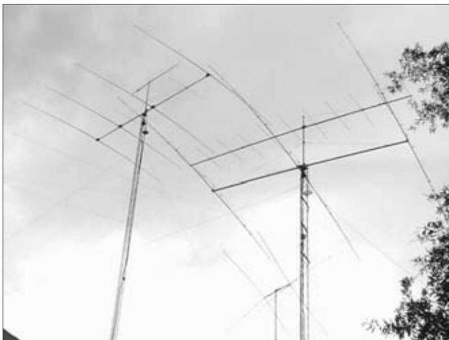
Larry, KJ4UY, perdió sus antenas a causa de un ciclón el año pasado. La foto muestra con qué las ha sustituido: En la torre de la izquierda hay una Yagi SteppIR de 4 elementos a 33 m de altura con una Telrex de 8 elementos para 2 metros. La torre de la derecha soporta una Yagi de 3 elementos M2 para 30 y 40 metros con una Telrex de 11 elementos para 6 metros encima. Y atrás, aún hay más cosas...
