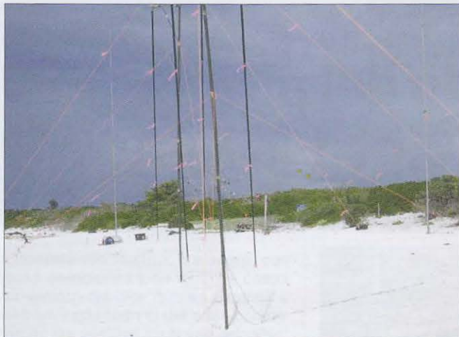
En las antenas, instaladas en la playa, se debieron situar cintas coloradas para ahuyentar a los pájaros.
