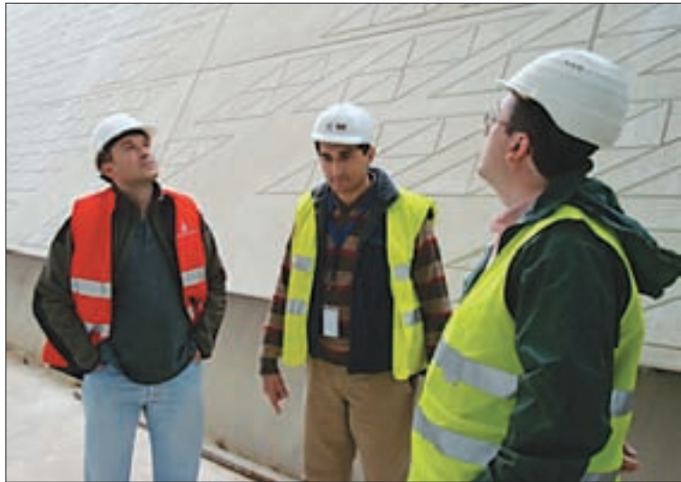
Visita a las obras de Expo, Roberto EA2EIE y José Luis, EA2COD acompañado del Sr. Sanz, responsable de obras.
