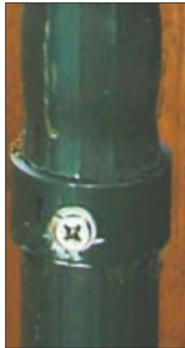
Foto B. Tornillos empleados para sujetar las secciones de aluminio entre sí.
