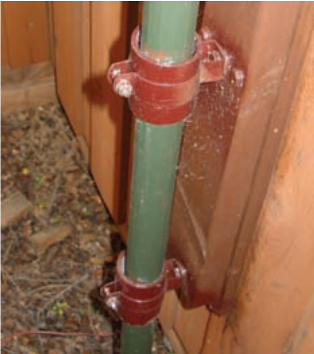
Foto E. Escuadras de montaje de vallas y tubo de PVC de 5 centímetros soportan la antena. El PVC fue pintado de marrón para adaptarlo al color de la valla.
