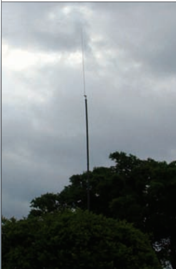
Foto F. Vista de la antena a lo lejos.
