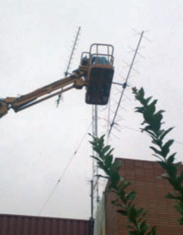
Foto A: Las antenas son izadas en la torreta por medio de una grúa, cedida por el Ayuntamiento.
