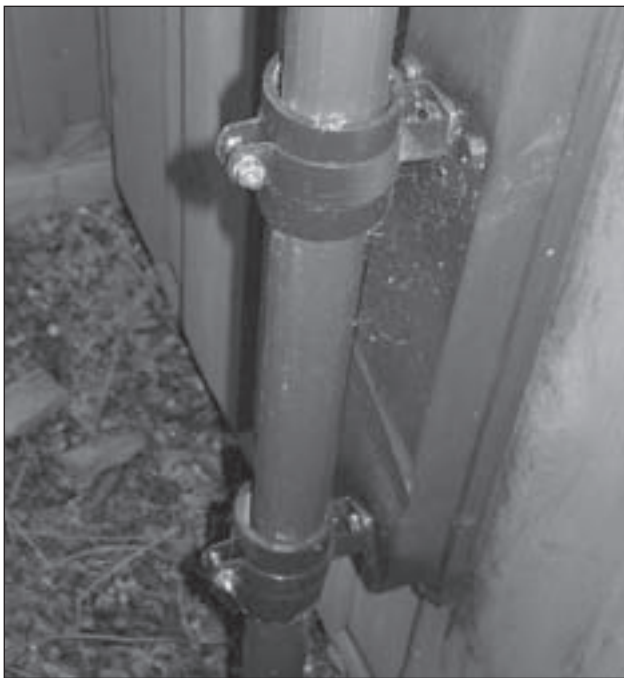
Foto C. La antena tiene una sección inferior, en tubo de cobre, enterrada en el suelo del jardín como toma de tierra. En otras ubicaciones será necesario imaginar otras soluciones para la "contraantena")
