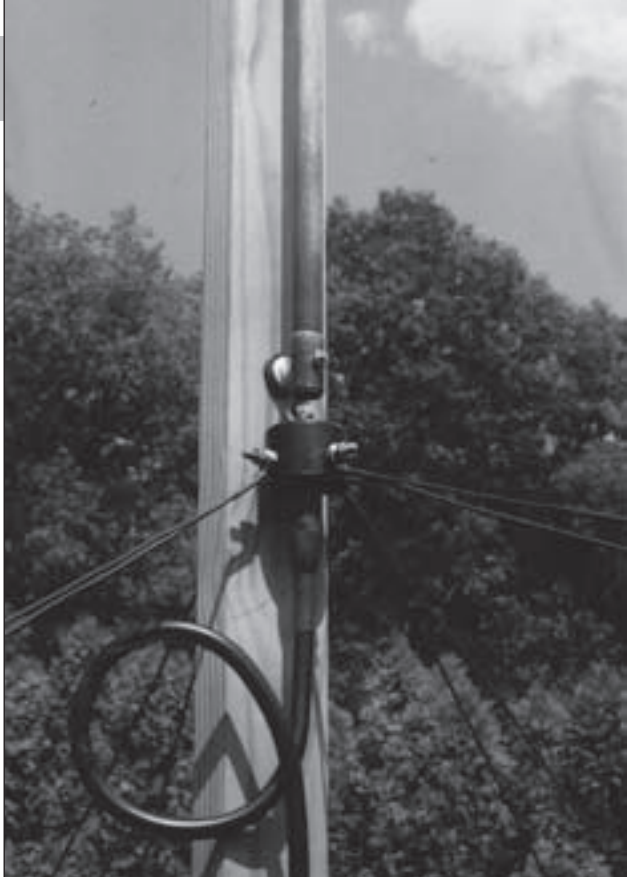
Foto F. Detalle del montaje de la alimentación conectada al radiante vertical mediante malla de coaxial. Cuatro pares de radiales constituyen el plano de tierra artificial.
