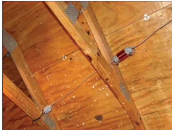
Foto D. Fotografiar el extremo del dipolo multibanda de Joan Jones, W4JMJ ha sido todo un desafío que afrontamos para mostrar su preciado secreto. Igual que N6SL y muchos otros radioaficionados que triunfan sobre restricciones sobre antenas, esta nos demuestra que un antenas a no demasiada altura puede hacer un buen papel (Foto cortesía de W4JMJ).
