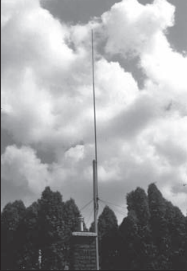
Foto A. La GP ya colocada para 20 m de K3RK. Observa que esta foto fue tomada antes de colocar el sombrero capacitivo.
