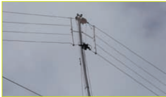
Foto B. Detalle de la sección central de la antena "Charli", mostrando el balun de alimentación, el aislador central y los espaciadores en tubo de PVC.
