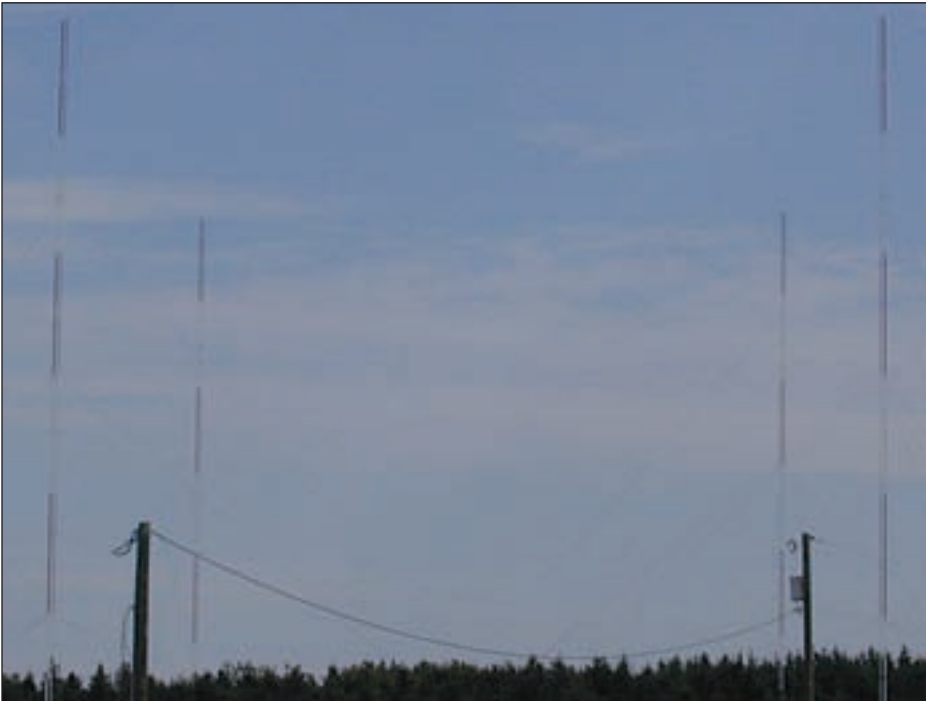
Foto B. El sistema radiante orientable transversal/colineal de 2 x 2 radiantes verticales para 160 m de VY2ZM. Una vista más amplia del campo de antenas puede verse en la foto de inicio (Fotos cedidas por Jeff Briggs, K1ZM/VY2ZM).
