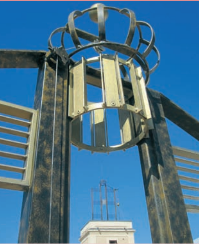
Foto E. Vista en detalle del mecanismo indicador con el que se codificaban los mensajes.
