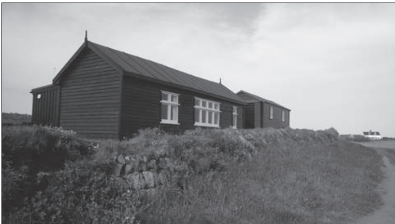
Foto D. Vista exterior de los edificios restaurados de la estación inalámbrica en The Lizzard.
