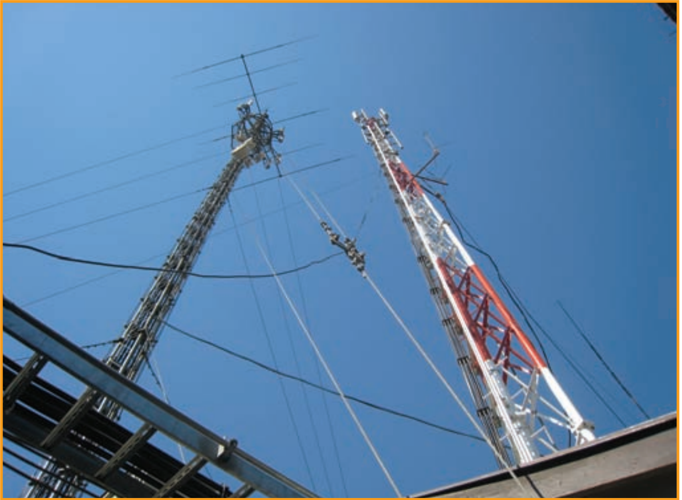
Foto C. Antenas de CE3AA, junto a una torre alquilada a una compañía de telefonía celular.
