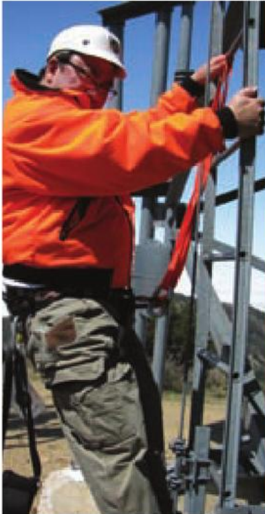
Foto 3. La primera y principal regla de seguridad es permanecer sujeto a la torreta en todo momento, incluso durante la ascensión. La torreta que se muestra aquí dispone de una escalera que simplifica el ascenso. En esta foto puedes ver la cinta roja de tejido de nylon que está bien sujeta a mi cinturón y anclada a uno de los travesaños al lado de mi mano izquierda
