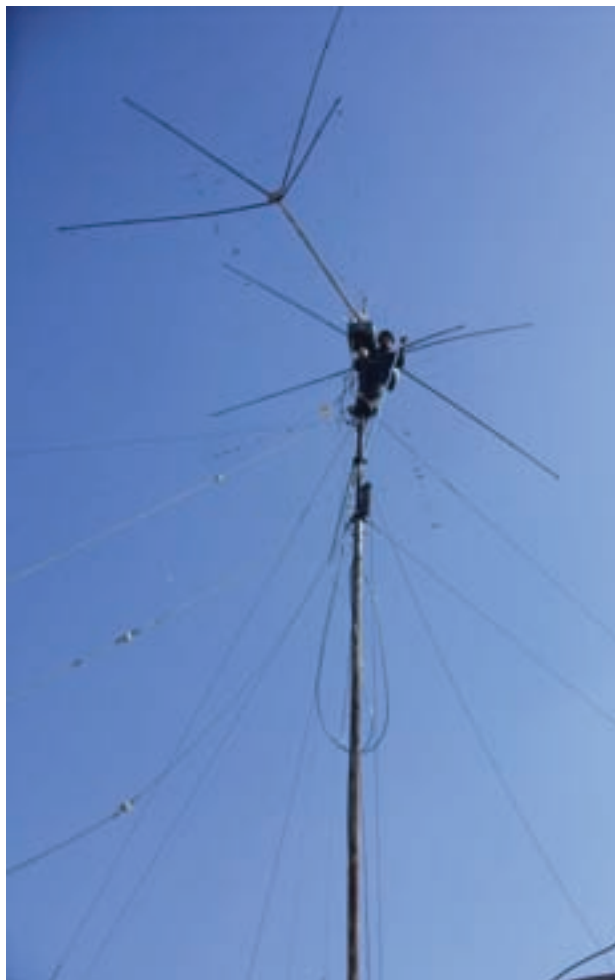
Foto B: Todas las antenas de UXOFF son de construcción propia y cubre todas las bandas de radioaficionado desde los 160 a los 2 metros EME.
