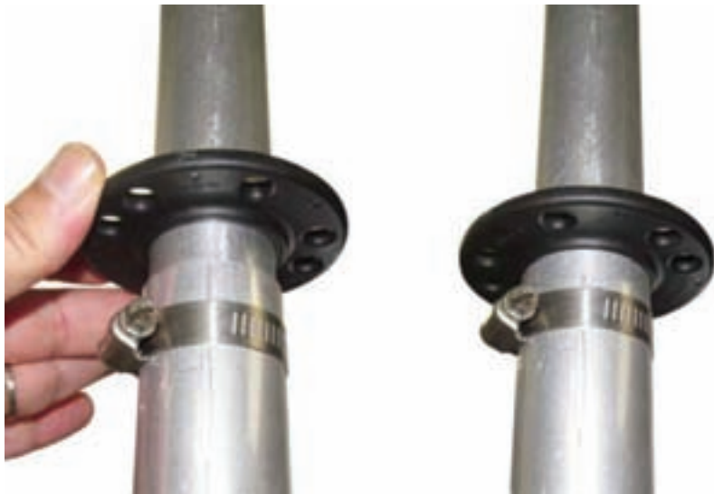
Foto C: Instalación de los anillos de arriostado de DX Engineering. Desliza cada anillo sobre el segmento telescópico adecuado y déjalo descansar sobre el tubo de mayor sección (foto cedida por DX Engineering).
