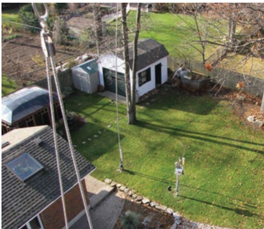
Foto B: Esta foto muestra la antena TABA montada en el espacio disponible en una superficie de hierba y un reborde bajo el que se esconde la contraantena, que comienza en la antena y se coloca alrededor formando aproximadamente un rectángulo algo irregular. La antena está a la izquierda, justo cortando la vista de la puerta del garaje en la foto.
