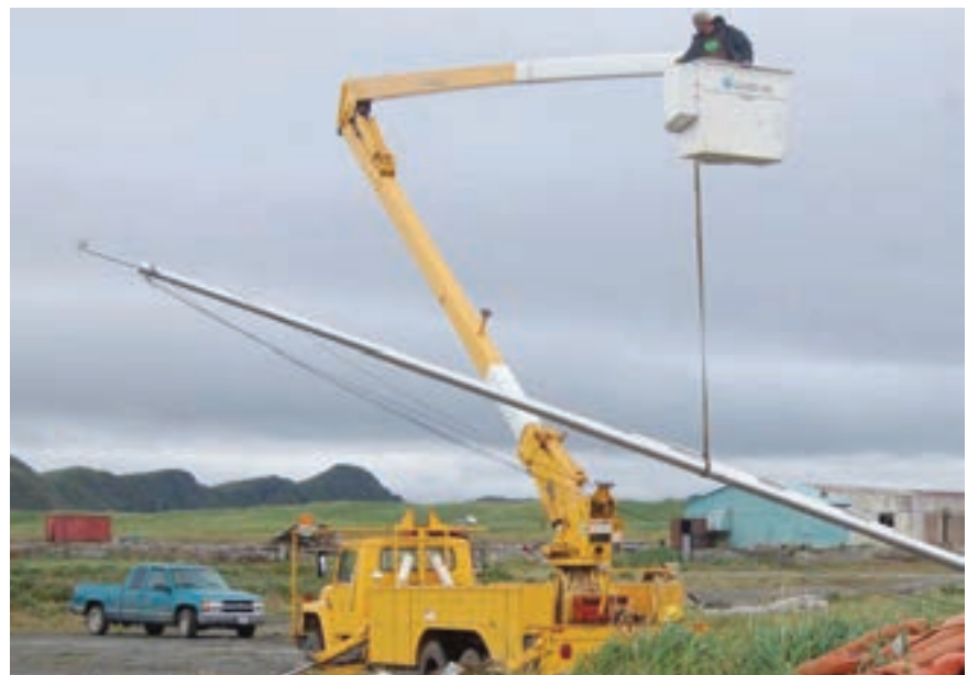
Foto C: Después de que los mástiles de las antenas quedaron montados, los constructores utilizaron un camión con brazo y cesta articulados para ponerlos en posición (Foto cedida por Ethan Miller, K8GU).
