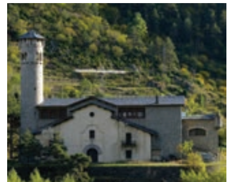
Edificio de Radio Andorra
