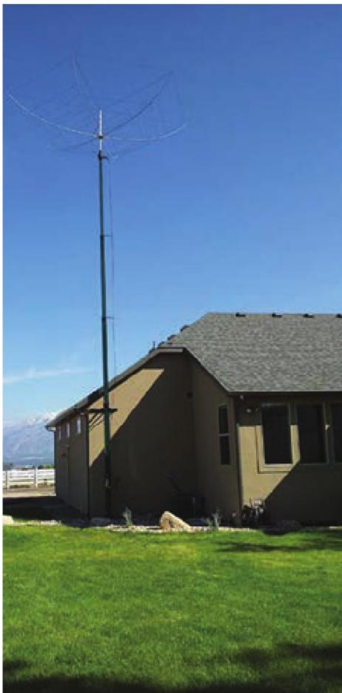
Bryon Densley, W7RIV, ha reemplazado su antena de cuadro vertical por una direccional K4KIO hexagonal a 13 metros de altura sobre una torreta Force 12 LPT 1242.
