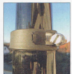
Bild 3: Schlauchschelle zur Sicherung eines Mastsegments, wie im Text beschrieben
