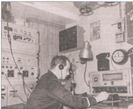
Bild 6: Empfänger Dabendorf im Funkraum des Typ-IV-Schiffes MS Leipzig
