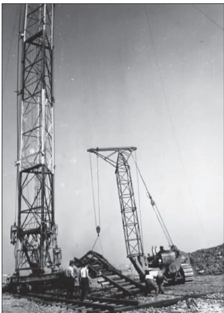
Verschiebung des 282 m hohen Sendemastes im Jahr 1959 Quelle:
