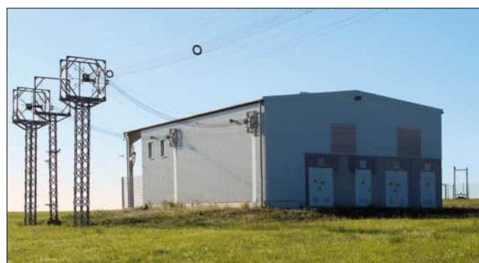
Sendegebäude für den 2014 installierten, volltransistorisierten 750-kW-Sender neben der Reserveantenne, zu der ebenfalls eine Reusenleitung führte
