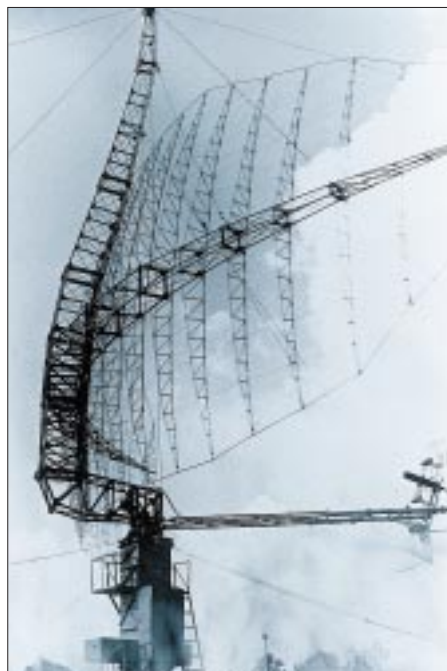
Meterwellen-Station P-14F zur Fernaufklärung: Die Parabolantenne ist 32 m breit. Die Antennenabspannungen sind zur Verhinderung von Eisablagerungen beheizbar.
