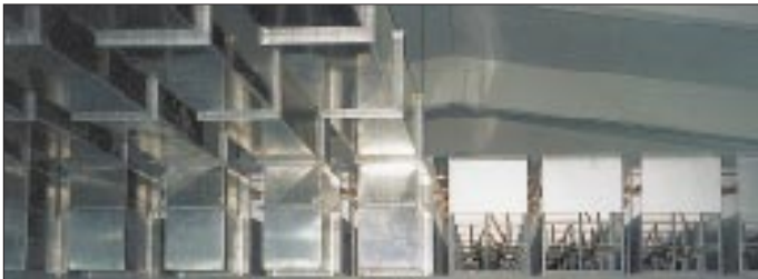
Teil des Kühlsystems eines 500-kW-Senders
