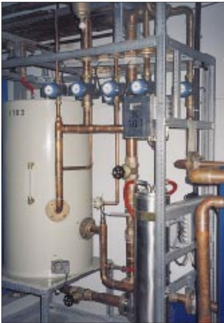
Teil des Kühlsystems eines 500-kW-Senders
