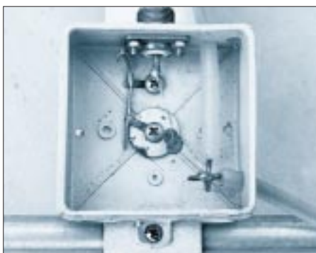
Bild 3: Die Ausführung der Koaxialkabel-einspeisung
