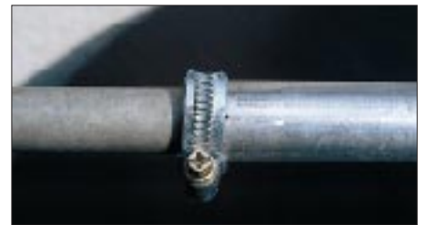
Bild 2: Rohrarrretierung mit Hilfe von Schlauchschellen und Schlitten
