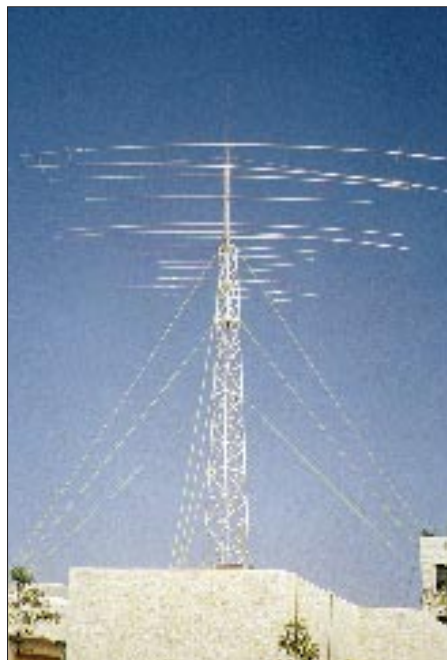
Basis für die guten Signale von JY9QJ ist ein 15 m hoher Gittermast auf dem Dach eines Ammanner Hauses.
