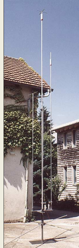
Fertig errichtete Antenne sowie unterer Rohrsteckaufbau mit Einspeisung und abgleichbereiten Fußpunktpulen
