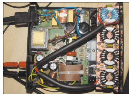
Bild 5: Zum Schutz vor Störstrahlung erhalten die 12-V-Leitungen durch den Mantel eines Koaxialkabels eine zusätzliche Schirmung. Fotos: DC1DV
