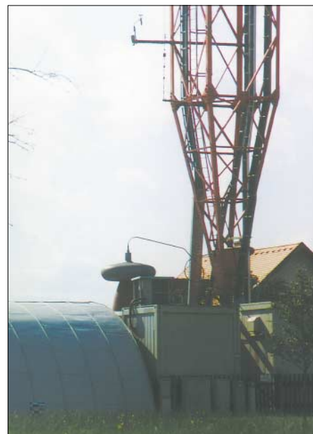
Fußpunkt des Antennenmastes im Vergleich zu einem Einfamilienhaus, links neben der Antenne steht das tonnenförmige Abstimmhaus.
