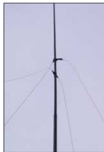
Bild 2: Die Spitzen der Dreiecke werden mit Isolierband am Mast befestigt. Gut geeignet ist Temflex-Band von 3M.
