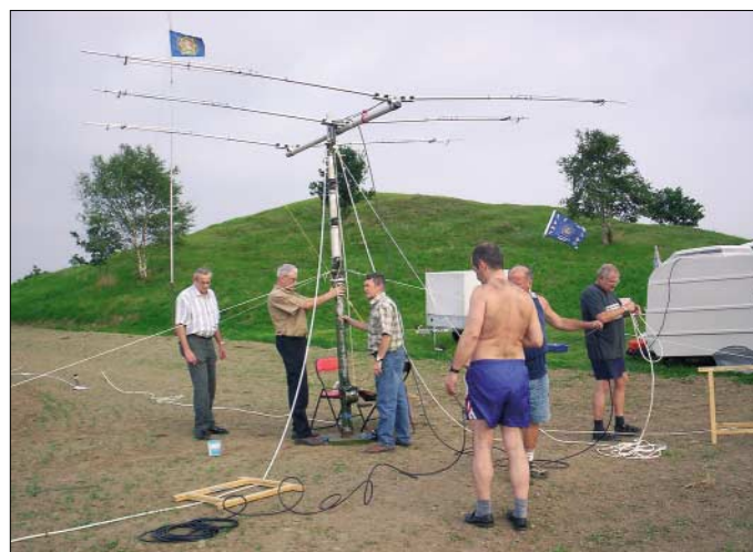
Die OMs beim Errichten und Probelauf einer 3-Element-Yagi für 20 und 15 m Fotos: DL1JGG
