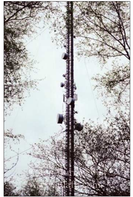
Die Antennen von GB3VHF befinden sich auf einem Sendemast der BBC. Eine der Yagis ist links zwischen den beiden untersten Spiegeln zu erkennen. Foto: G0AFH
