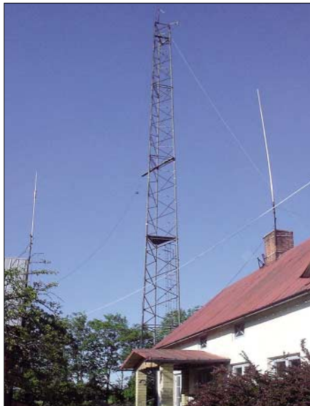
Die Antennenanlage von Kjell, SM1LCA, auf der Insel Gotland Foto: DK8KW
