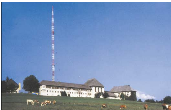
Abspannseile sichern den 156 m hohen und 40 t schweren Antennenmast.
