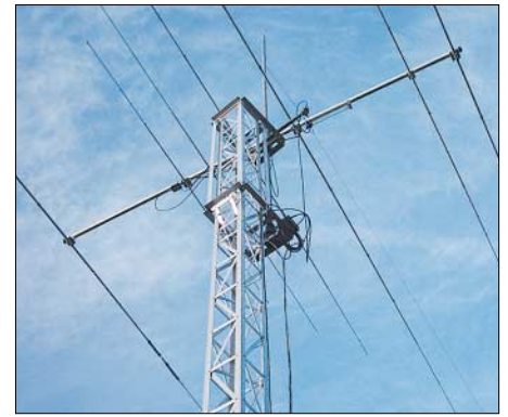
Bild 4: Einspeisung der FD5 mit 1:6-Balun Fotos: DL7PP
