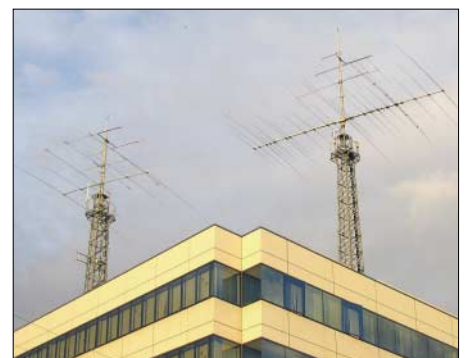
Imposante Antennenanlage auf dem ICOM-Hauptgebäude in Osaka
