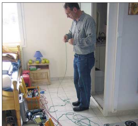
Letzte Vorbereitungen in Sachen Kabel
