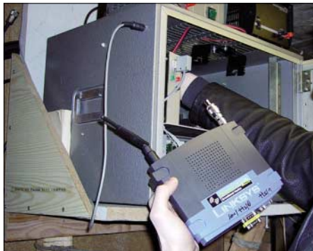
Einbau des WLAN-Routers
