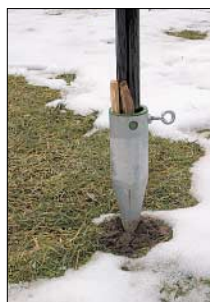
Bild 1: Der 12,5-m-Glasfibernast passt sauber in einen Wäscheständer-Schraubfuß; einige Holzkeile sorgen für senkrechte Ausrichtung.
