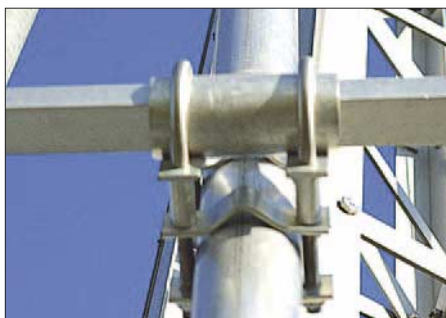
Bild 3: Detailansicht der Mastaufnahme mit Doppelschelle. Das ist während der Befestigung eine wacklige Angelegenheit. Die Hülse auf dem Boom sollte man zuvor arretieren.
