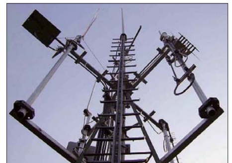
70- und 23-cm-Antennenanlage bei DB0BOS (Böllstein/Odenwald) Foto: DG9FCJ
