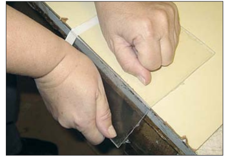
Bild 7: Samt der Schutzfolie lässt sich das geritzte Bauglas über eine Kante brechen.
