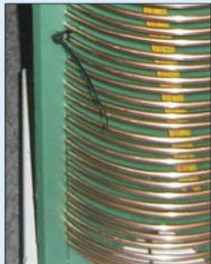
Bild 11: Teil der fertig-gestellten Spule mit abschließend wieder montierten Kunststoffleisten
