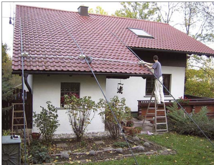
Bild 1: Die fertige Antenne vorm Aufstieg zum Mast
