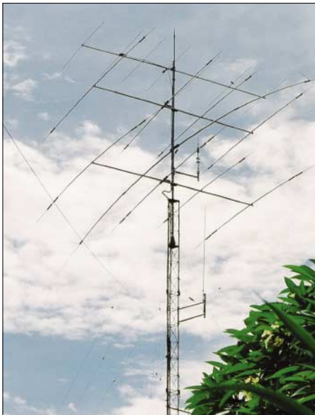
Der 25 m hohe Antennenmast von YB9AY mit den Mehrelement-Yagis für Kurzwelle und 50 MHz
