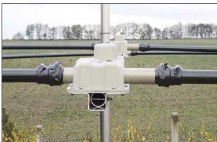
Bild 16: Eingesetzte Elemente mit zusätzlich unwickelten Muffen
