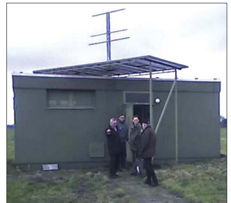
Bild 4: Betriebsgebäude mit darauf angebrachter „OM“-Antenne für die Anflugbefehung Fotos: DK1KQ
