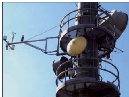
Die HB9AK/B-Rundstrahlantenne mit etwa 10 dB Gewinn (rechts). Die Antenne ist Richtung Südosten durch den Mast abgedeckt. Foto: Swiss ARTG
