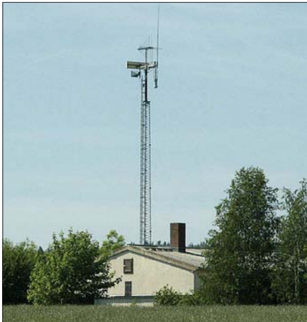
Bild 1: Drehbarer Peilerkopf auf 20-m-Gittermast
