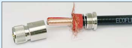
Bild 6: Der Schaftkegel ist vollständig zwischen Geflecht und Mantel zu schieben.
