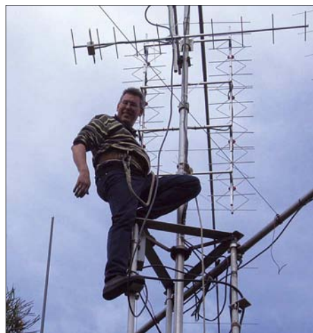
DF1JM bei Arbeiten am Mast
