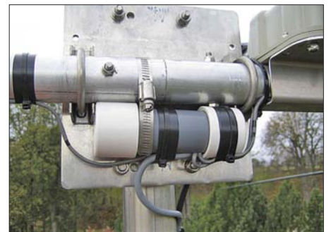
Bild 13: ... fertig montierten Kabelgehäuserohr an der Boomplatte ziehen Fotos: DC9AT
