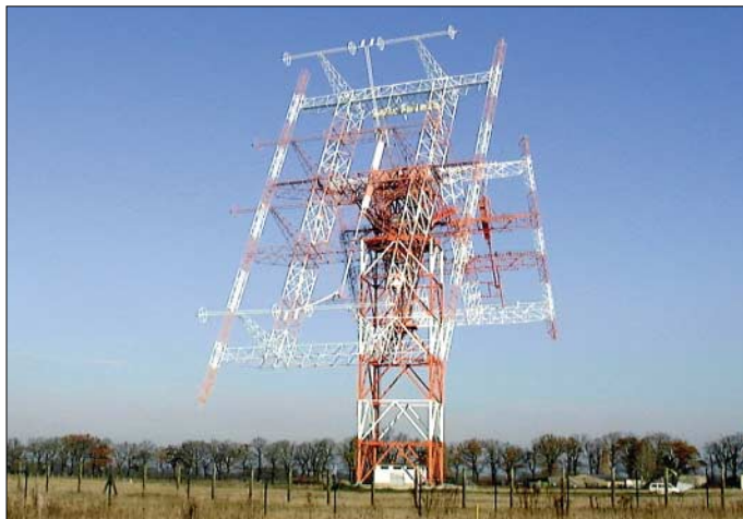
Die breitbandige Nauener „Dreh- und Schwenkbare“ der Deutschen Welle überstreicht ein Frequenzspektrum von 5,9 bis 18 MHz mithilfe von je zwei Dipolreusen nebeneinander und vierein übereinander: 2/4 (rechts) für die längeren Bänder sowie 4/4 (links) für die kürzeren.
