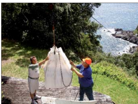
Materialtransport per Seilbahn („flying fox“)
