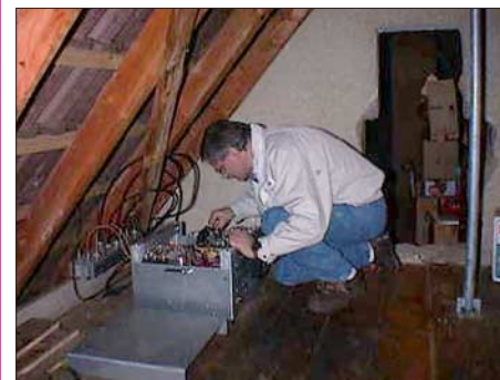
Abgleicharbeiten beim Digipeater DB0ASF (Aschaffenburg) am Link zu DB0GV Foto: DB0ASF
