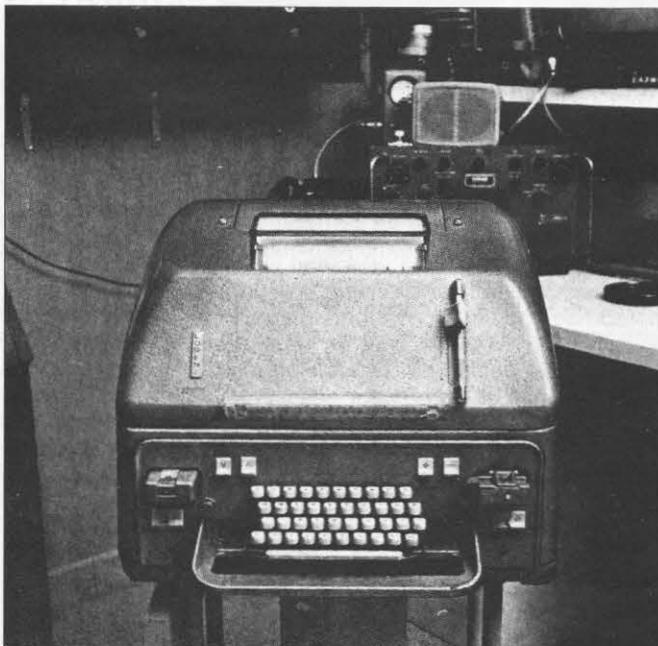
Foto B. Teleinscriptor electromecánico de página, usado como terminal de RTTY en una estación de radioaficionado.
