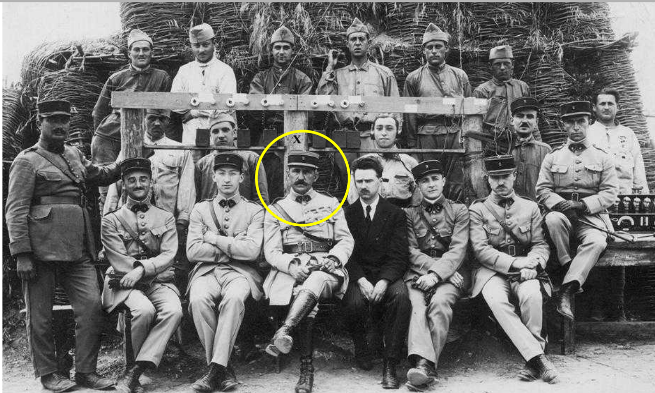
Sur cette photo, regardez le ou les postes à lampes à droite et les batteries à l'arrière plan
