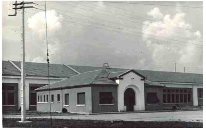
Centre Emetteur du Vernet. Bâtiment d'émission E2
