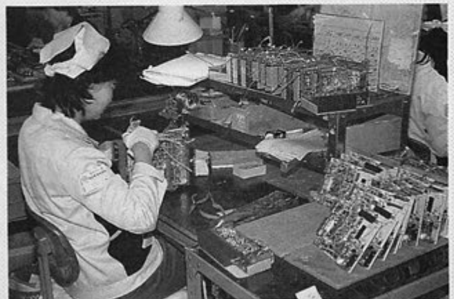
Insertion des sous-ensembles dans les boîtiers.
